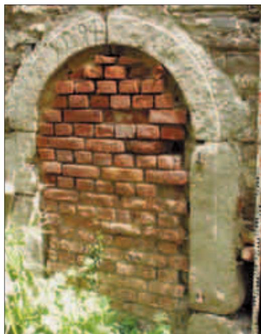
Ostfassade wird in dieser Ebene von einem Okulus durchbrochen, dessen Kalksteingewände wie die gefasteten Rechteckfenster gestaltet worden ist. Die Rundbogentür des 2. Obergeschosses in der Nordfassade wurde durch Einbau einer Ziegelscheibe nachträglich zu einem Okulus umgebaut.
